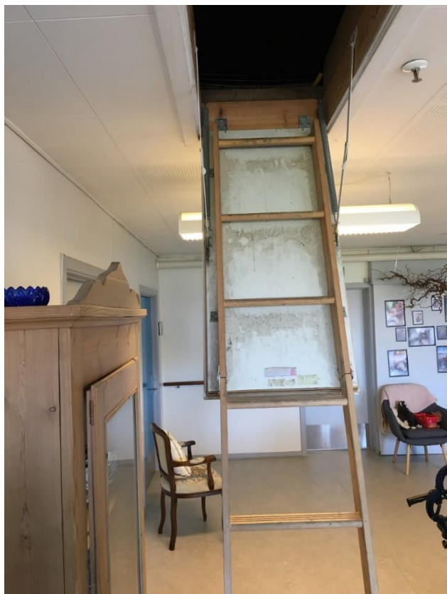
Figur 6 - Loftlem til loftrum over dementes afsnittet
