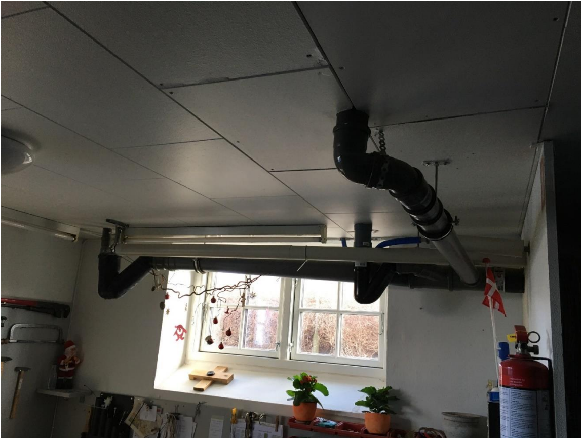
Figur 3: Manglende brandsikring og brandtætning ved faldstammer/afløb udført i plast i kælder
