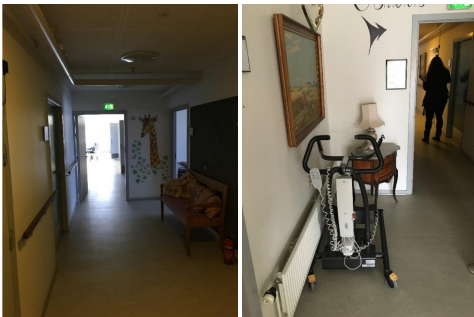
Figur 10 - Opbevaring af møbler og elektronisk udstyr i flugtvejsgange (6.5.1 stk. 1)
