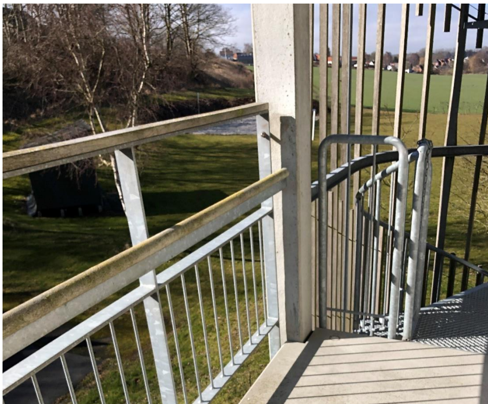
Figur 12 - Altangange og flugtvejstrapper fra 1. og 2. sal ved ældreboliger er udføres uden mulighed for båretransport, samt skal indplaceres i egen brandsektioner. Samtidig skal trapperne udføres som bygningsdel klasse R 30 / A2-s1,d0 [BS-bygningsdel 30].
