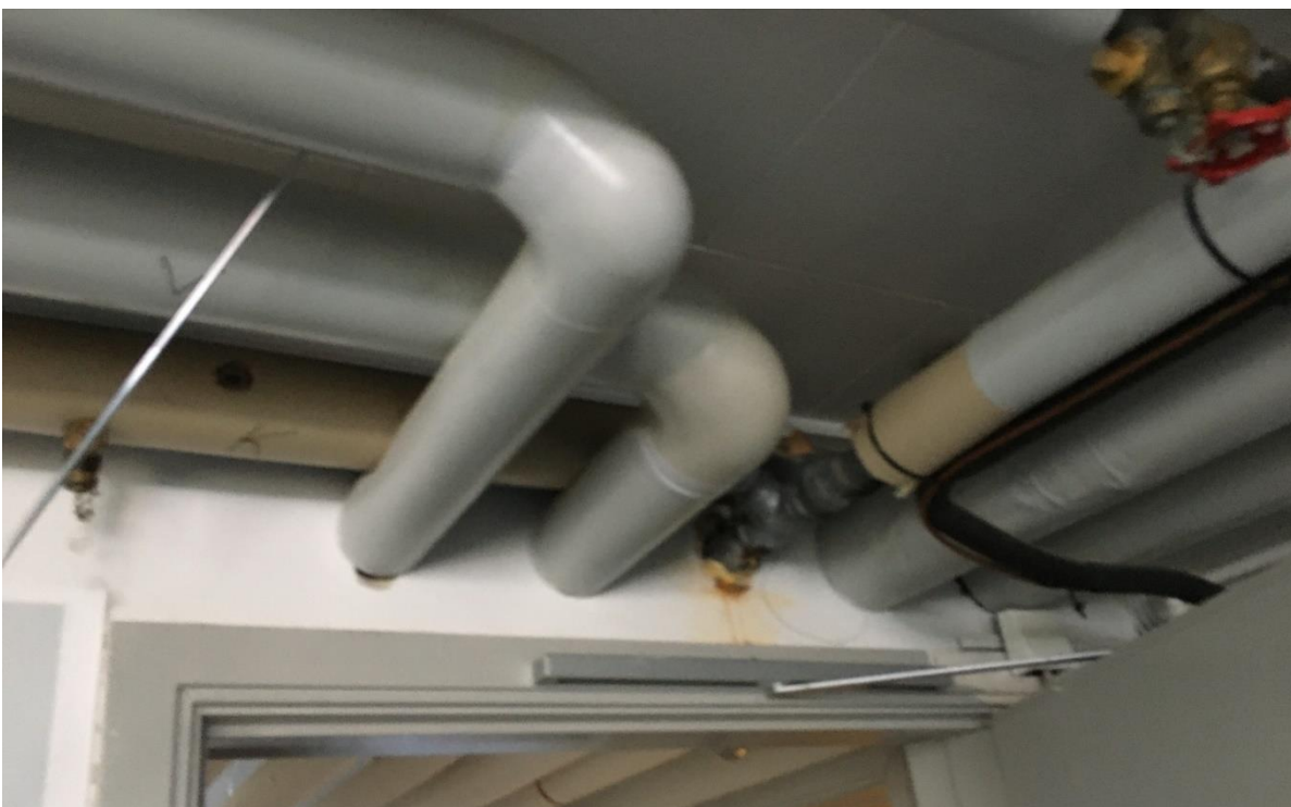
Figur 4: Manglende brandtætning ved installationsgennemføring i kælder
